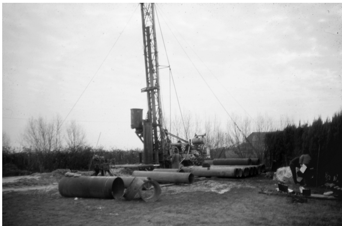
Fig. 5.9 – Realizzazione del pozzo Olimpia eseguita con il metodo a percussione nell'anno 1986 (foto E. Castellaccio).
