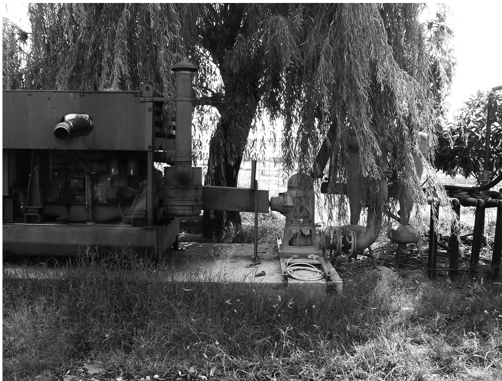
Fig. 5.27 – Pozzo ad uso irriguo ed antibrina di pertinenza alle piantagioni di kiwi nella pianura del “Campagnon”. La notevole portata di emungimento (circa 80 l/s) viene assicurata da una pompa meccanica azionata con motore diesel (foto E. Castellaccio).
