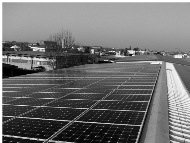
Fig. 6.9 – Installazione di pannelli solari a servizio dell'impianto termico (foto L. Micheletti).
