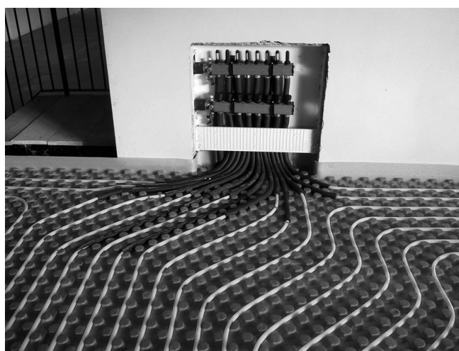
Fig. 6.12 – Particolari di posa del sistema di riscaldamento con pannelli a pavimento (foto Aktis Italia s.r.l.).
