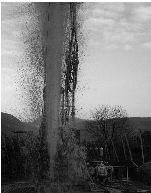
Fig. 6.17 – La produzione idrica di un pozzo termale durante la perforazione eseguita mediante aria compressa e schiume biodegradabili (foto E. Castellaccio).
