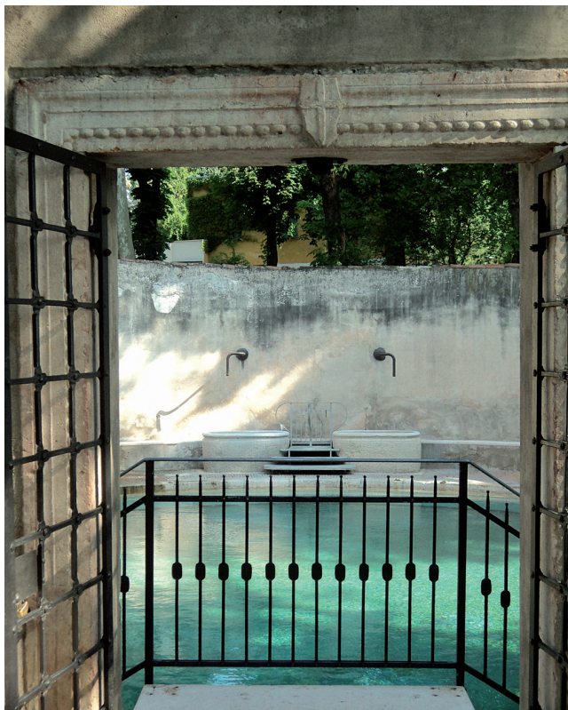
Fig. 5.7 – Ingresso della piscina Brentella e sullo sfondo il muro circolare di delimitazione (foto E. Castellaccio).
